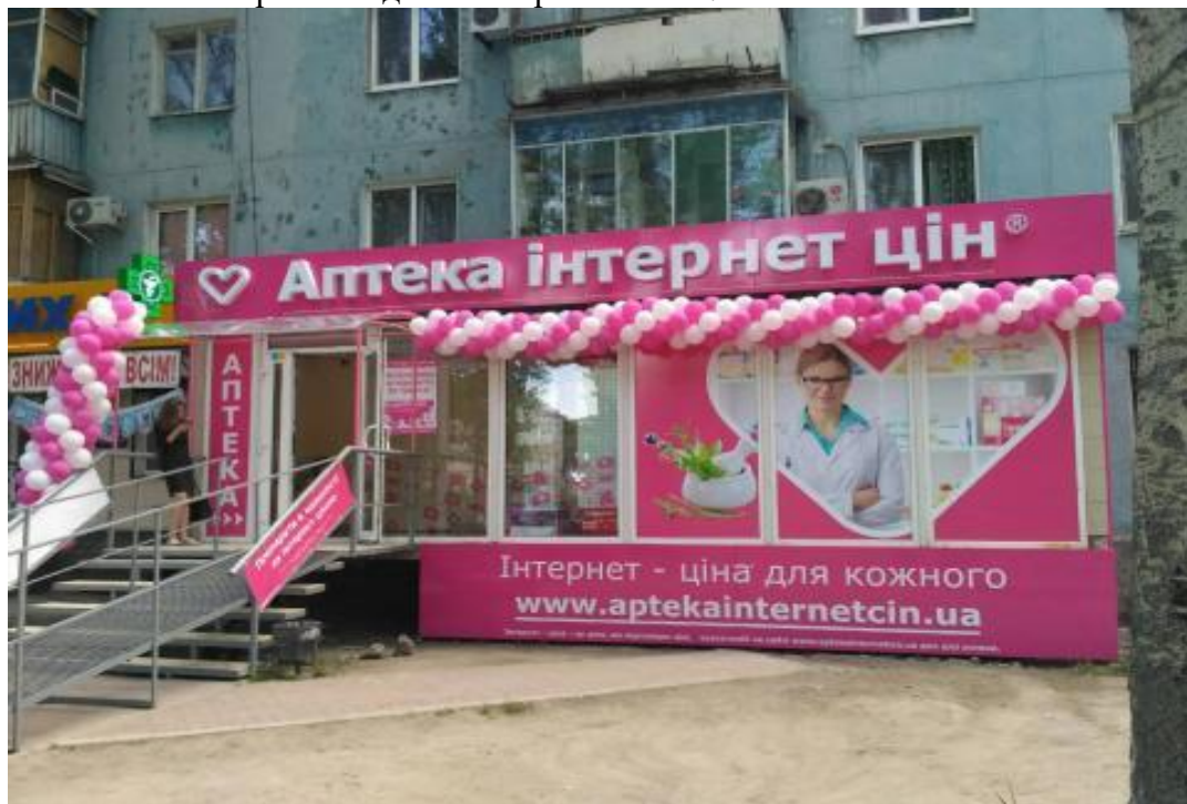
Фотокопія. Фото фасаду аптеки Товариства № 75, розташованої у м. Запоріжжя, вул. Щаслива, 3, прим 42, літ А-5.
